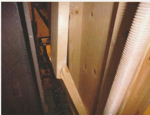
写真4.2.11 筋かいの座屈(最終変形時)
