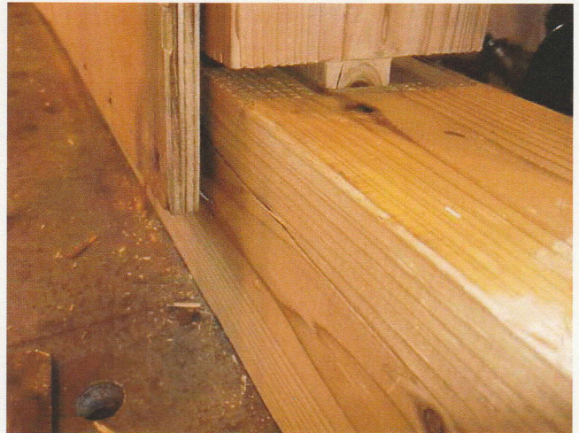
写真4.3.8 土台の割れ(最終変形時)(柱脚引張側)
