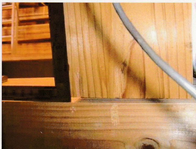
写真4.2.4 右柱脚の浮き(5mm程度)(1/100rad時(引き))
