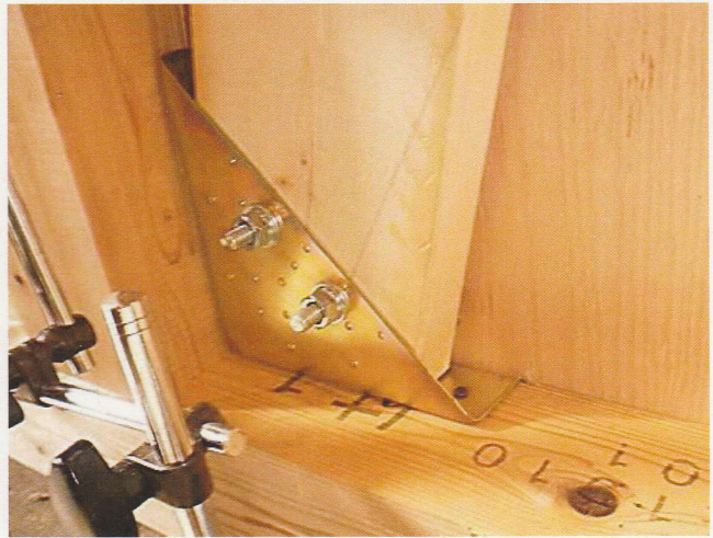
写真4.1.4 金物の変形(1/75rad時(押し))(柱脚引張側)
