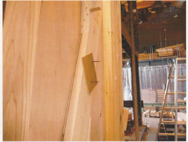
写真4.1.8 筋かい-筋かい留め付け釘の抜け(最終変形時)
