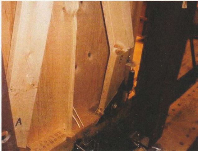
写真4.2.9 間柱の割れ(最終変形時)
