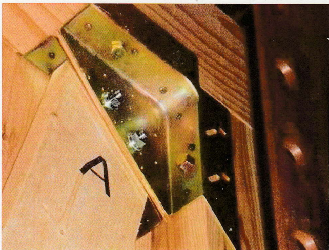
写真4.2.3 金物の変形(1/100rad時(引き))(柱頭引張側)
