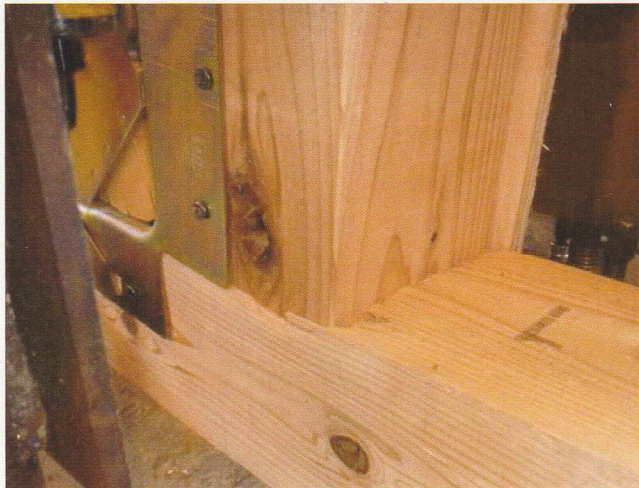
写真4.1.9 左柱木口の土台へのめり込み(最終変形時)
