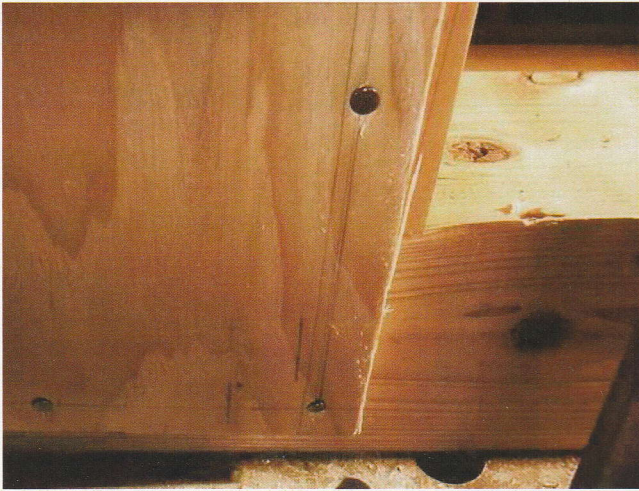
写真4.1.7 右柱脚木口の土台へのめり込み(1/50rad時(引き))
