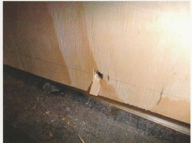
写真4.1.10 釘頭の面材へのめり込み(最終変形時)
