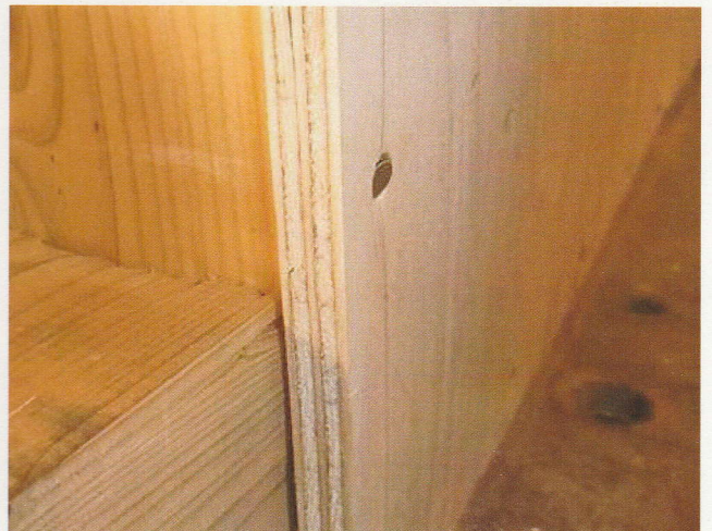
写真4.3.10 釘頭の面材へのめり込み(最終変形時)
