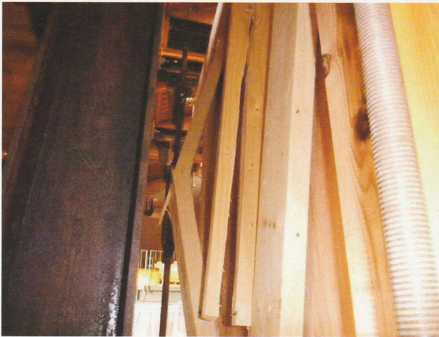
写真4.3.7 間柱の割れ(最終変形時)
