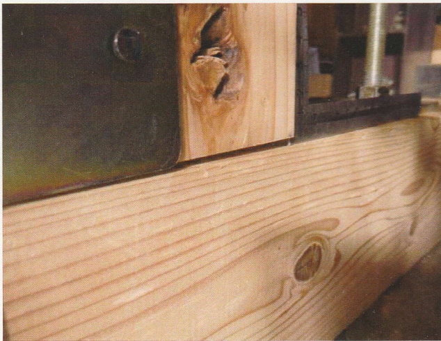
写真4.1.3 右柱脚の浮き(4mm程度)(1/100rad時(引き))
