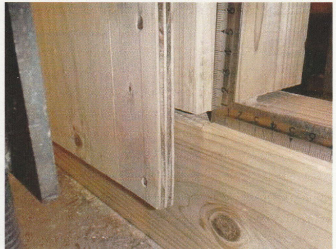
写真4.2.10 釘頭のめり込み(最終変形時)
