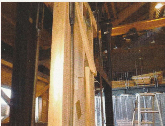
写真4.1.11 筋かいの座屈(最終変形時)
