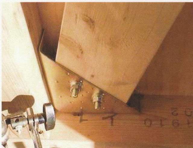
写真4.3.5 金物の変形(1/75rad時(引き))(柱脚引張側)
