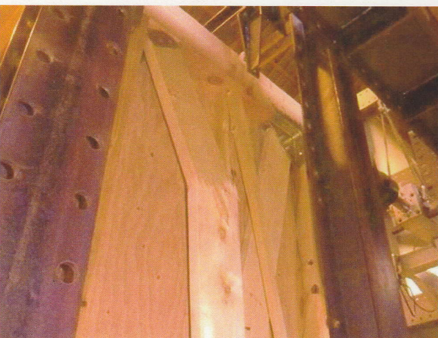
写真4.3.11 筋かいの座屈(最終変形時)
