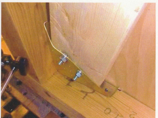
写真4.3.12 金物の変形(最終変形時)(柱脚引張側)
